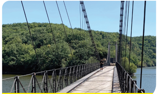
Suspension bridge over the Tardes, Évaux-les-Bains © Évaux-les-Bains Town Hall
